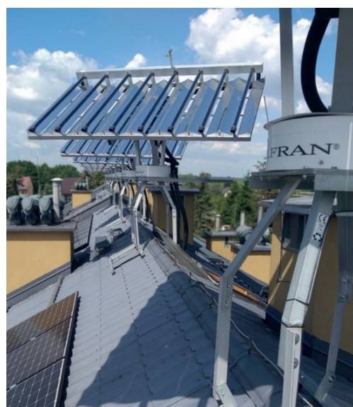
Rys. 4. Obrotowe kolektory słoneczne firmy ELFRAN umieszczone na instalacji demonstracyjnej w Krakowie
