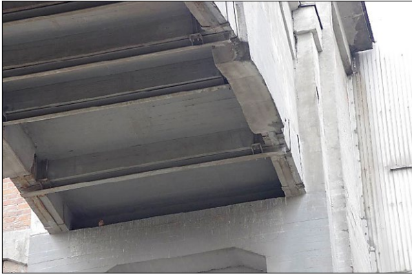
Fig. 11. View of reinforcements; photo by Ł. Bednarz Ryc. 11. Widok wzmocnienia, zdj. Ł. Bednarz
