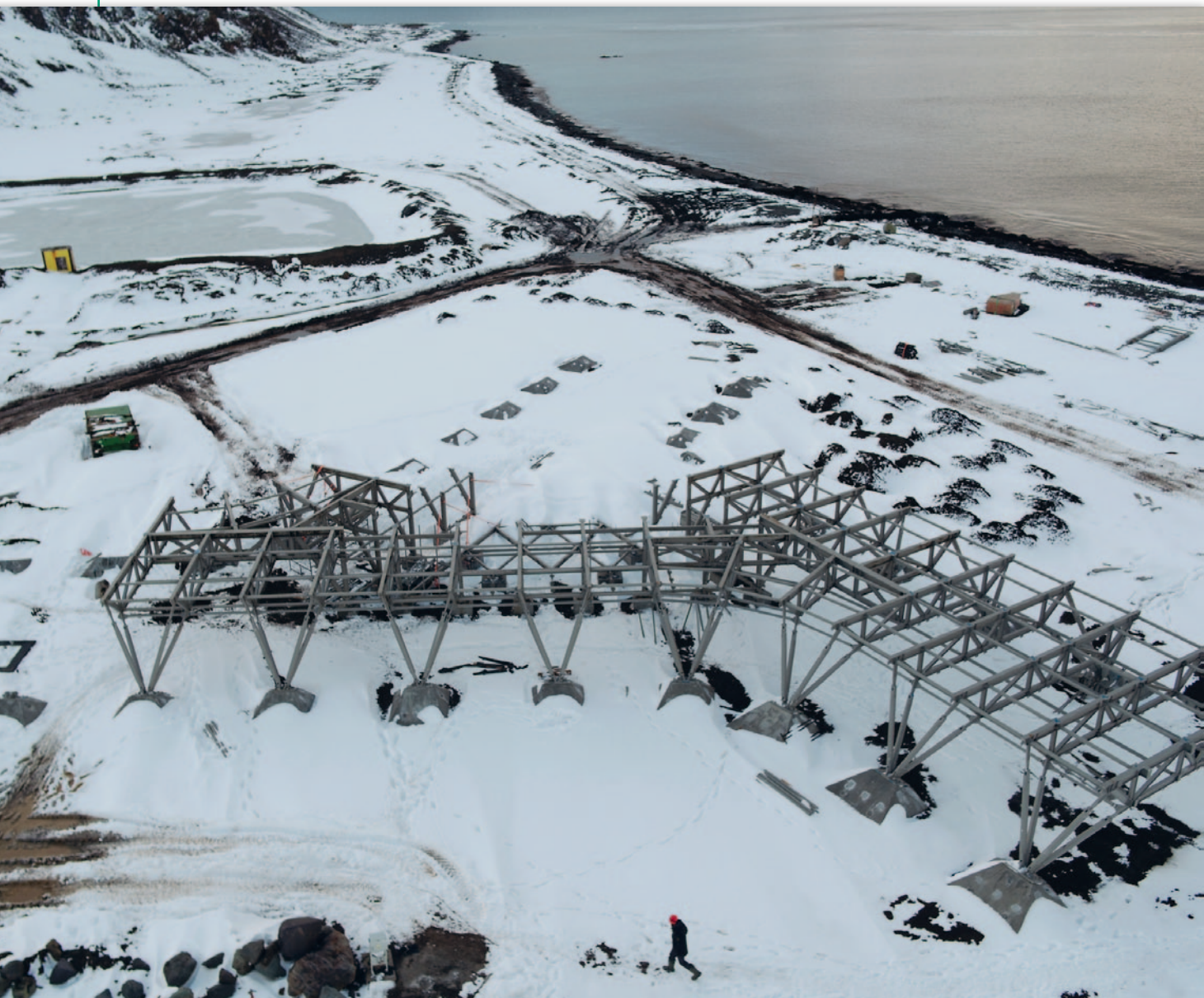
Stalowy szkielet głównego budynku stacji w marcu 2022 r.
