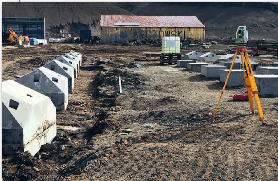
Tyczenie stóp fundamentowych głównego budynku stacji
