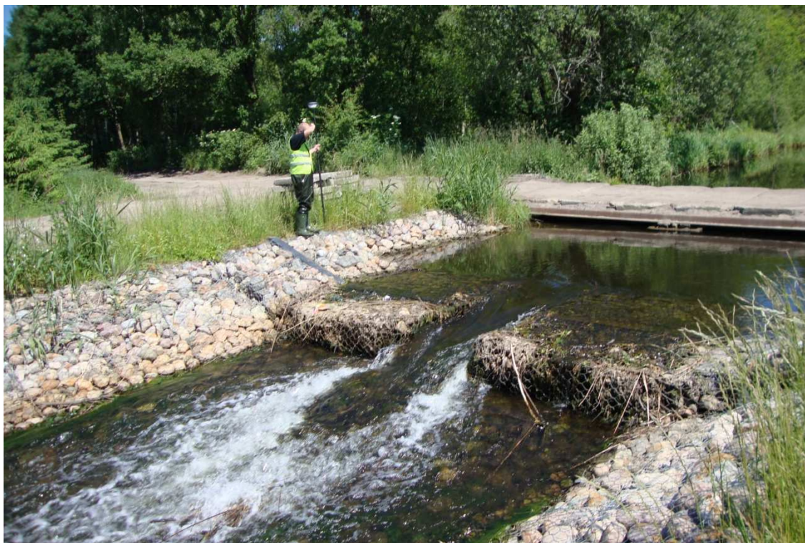
Rys. 1. Koryto rzeki oraz obiekt inżynierski (kładka)
