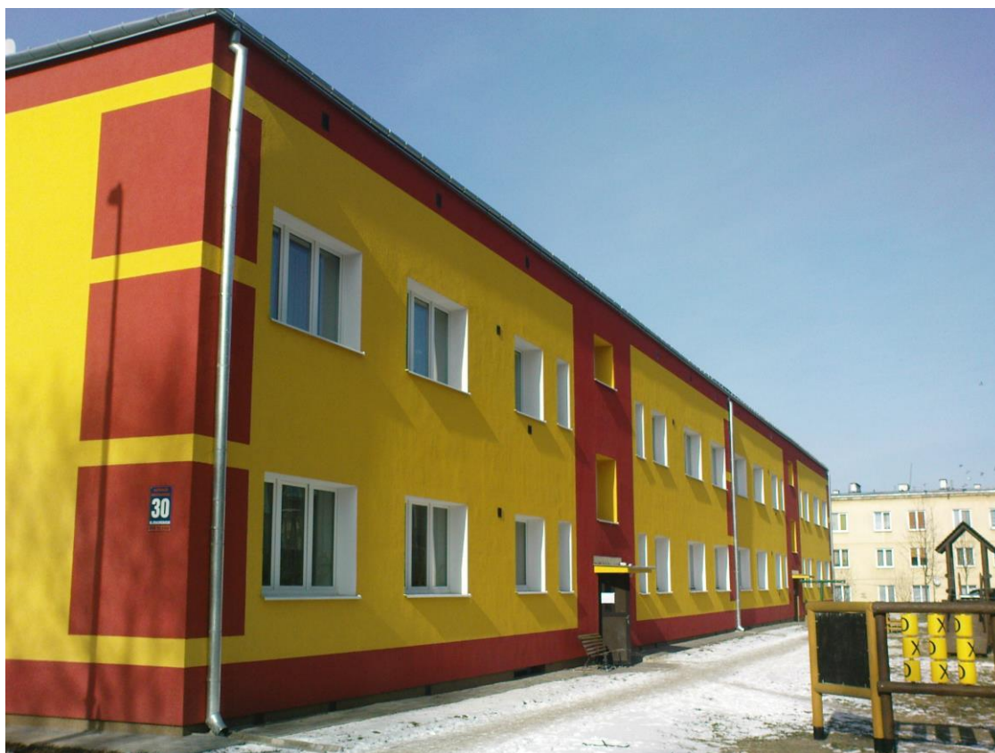
Il. 6. Termomodernizacja przedwojennych budynków mieszkalnych w Kraśniku, fot. autora Ill. 6. Thermal modernisation of pre-war residential buildings in Kraśnik, photo: author
