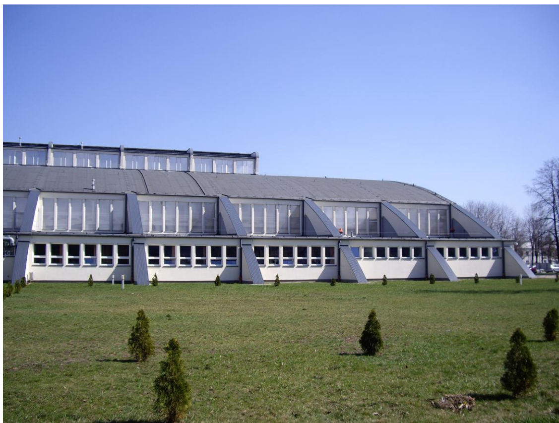
Il. 3. Wzorcową adaptacją budynków dawnej Wytwórni Płatowców w Mielcu do współczesnych wymogów produkcyjnych Sikorsky – A United Technologies Company, fot. autora
