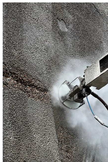
Rys. 8. Hydromonitoring powierzchni betonowej (archiwum autora)
