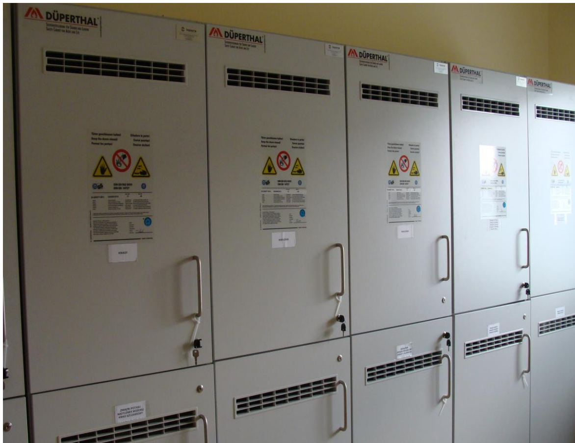
Fot. 2 Przykład oznakowania i zabezpieczenia szaf do przechowania substancji niebezpiecznych
