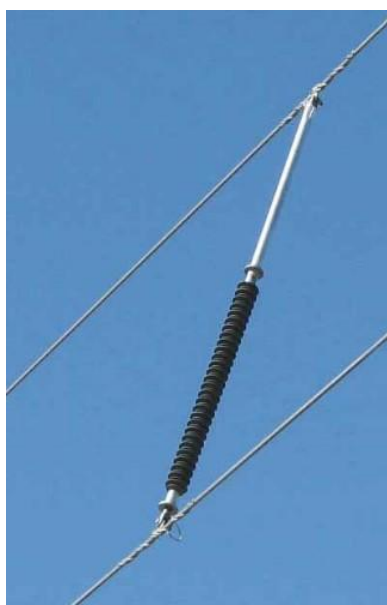
Rys. 9. Odstępnik tłumiący [10]
