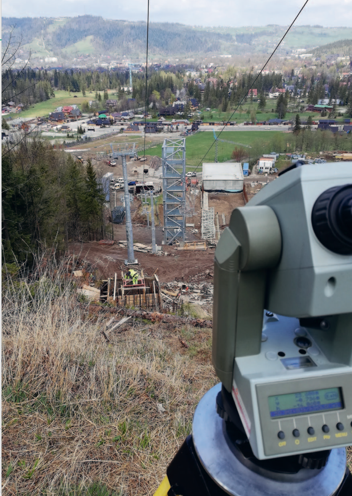
Początek przebudowy zespołu skoczni Średnia Krokiew w Zakopanem w 2020 r.
