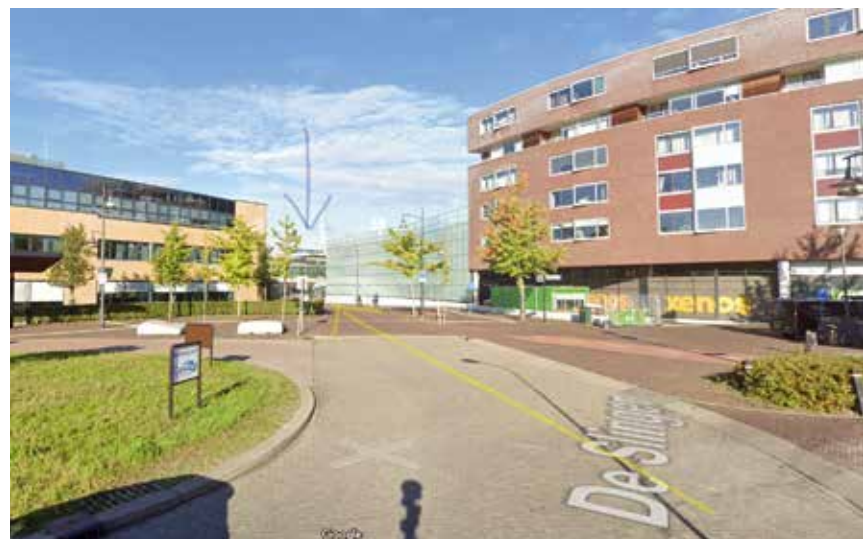
Rys. 8. Houten – widok wzdłuż południowego przejazdu w kierunku dworca; źródło: opracowanie własne na podstawie Google Maps
