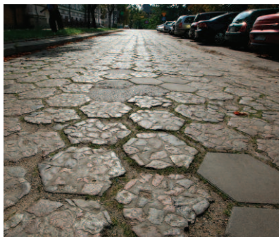
Photo 3. Trylinka (hexagonal concrete blocks) on Obrońców Warszawy Square Fot. 3. Trylinka na pl. Obrońców Warszawy
