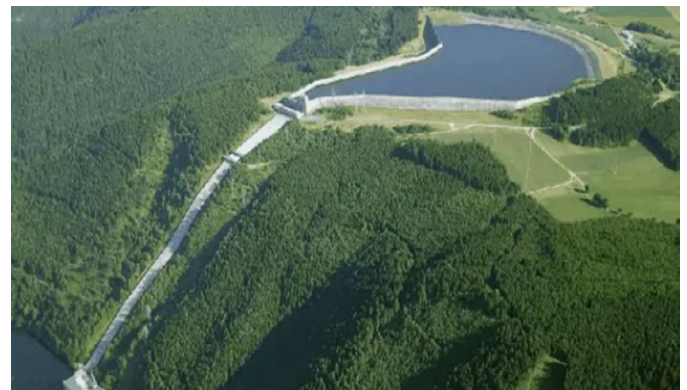
Fig. 8. View of the greatest storage-pumped power plant in China (Source: https://swiatoze.pl/elektrownia-szczytowo-pompowa-o-najwiekszej-mocy-zainstalowanej-na-swiecie-juz-dziala-w-chinach/ )
