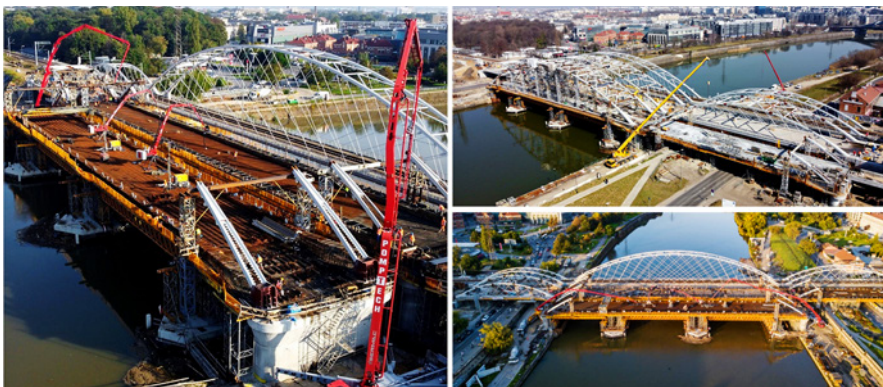
Ryc. 5. Mosty w trakcie budowy
