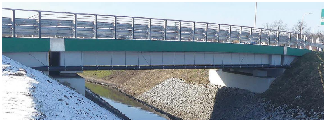
Rys. 7. Widok od strony wody dolnej po przebudowie mostu
