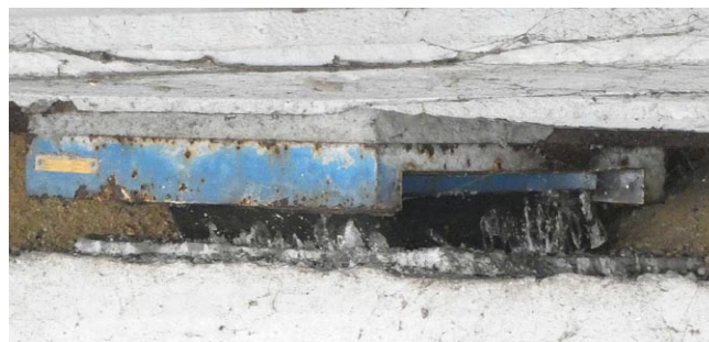
Rys. 4. Łożysko jednokierunkowe na przyczółku południowym (pod środkowym dźwigarem) przed przebudową
