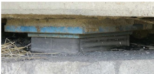
Rys. 3. Łożysko wielokierunkowe na przyczółku północnym (po stronie wody górnej) przed przebudową
