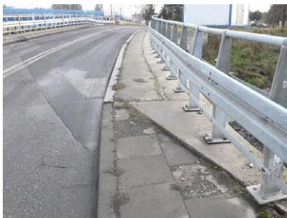
Rys. 5. Widok na strefę dylatacji po stronie północnej przęsła przed przebudową mostu
