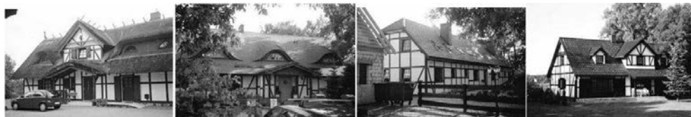
FIGURE 2. Selected examples of modern skeleton constructions alluded to traditional post-and-beam solutions in Cassubian huts – dwelling houses, Karwieńskie Błota (photo by Mirosława Górecka) RYSUNEK 2. Wybrane przykłady współczesnych konstrukcji szkieletowych nawiązujących do tradycyjnych rozwiązań ryglowych w chałupach kaszubskich, domy mieszkalne, Karwieńskie Błota (fot. Mirosława Górecka)
