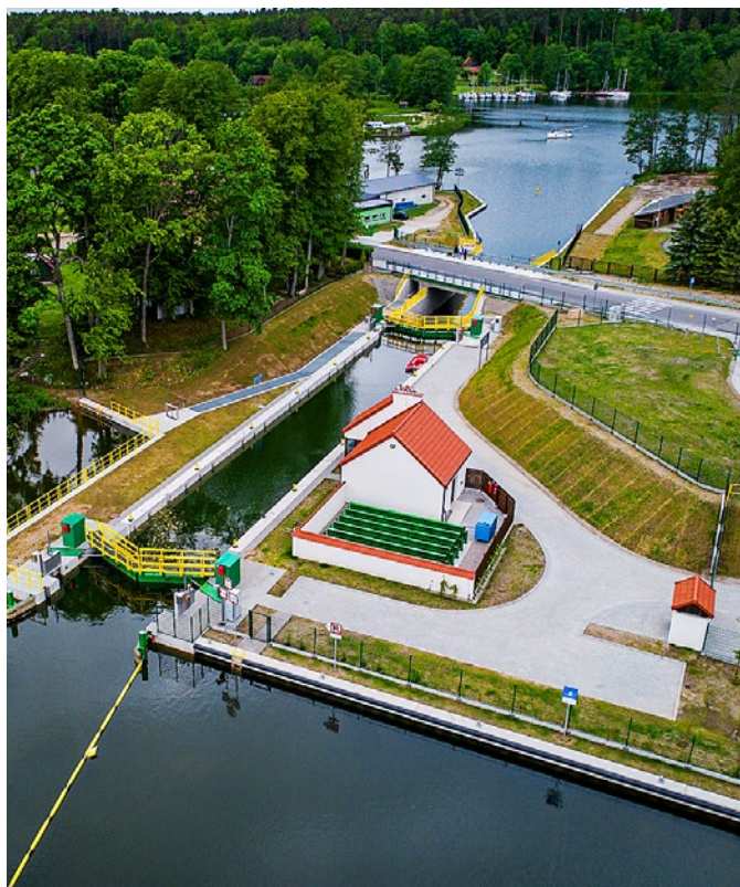
Zakończona w czerwcu 2020 r. budowa śluzy Guzianka II
