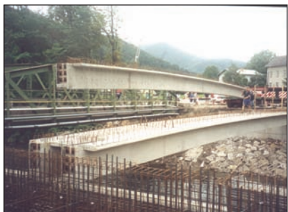
Fot. 3. Belki kablabetonowe z betonu B60 w ramowym moście zespolonym (projekt polskich inżynierów zrealizowany w Austrii)
