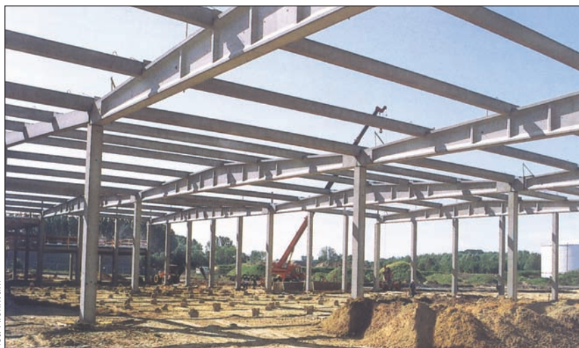
Fot. 1. Lekkie konstrukcje hal o siatce słupów do 20 x 40 m: sprężone słupy, dźwigary i płatwie z betonów B70 do B90, wg [3]
