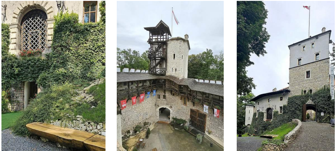
Fig. 62-64. Korzkiew, castle, exterior view and interior courtyard. Source: photos by author in 2024 Ryc. 62-64. Korzkiew, zamek, widok z zewnątrz i dziedziniec wewnętrzny. Źródło: foto autor, 2024
