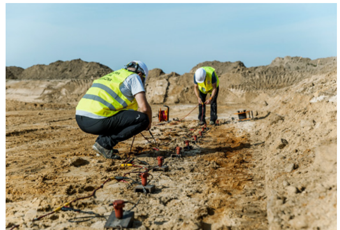
Ryc. 3. Badania sejsmiczne na dnie wykopu, fot. M. Szlasa
