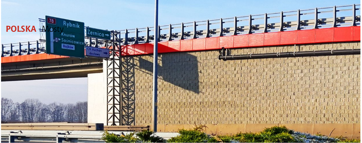
Ryc. 4. Gotowa konstrukcja obiektu
