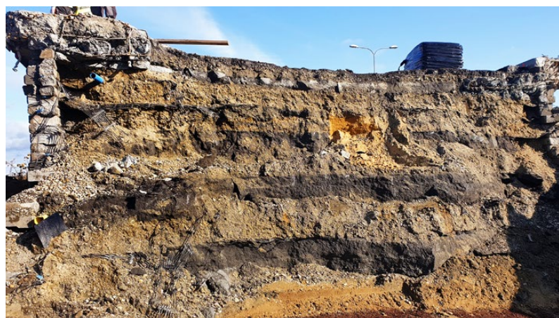
Ryc. 2. Przekrój rozbiieranej konstrukcji – widoczne warstwy materiałów zasypowych
