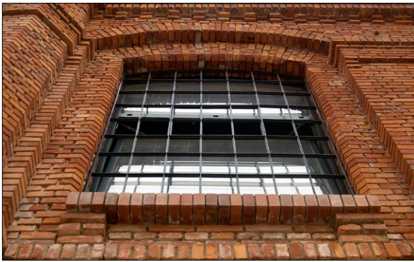
Ryc. 8. Kratownica okna fabrycznego zachowana in situ w adaptowanym budynku fabryki Ludwika Geyera; fot. autor
