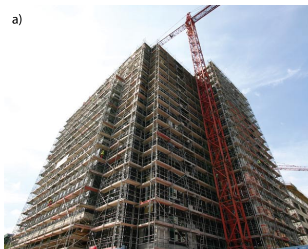
Rys. 1. Przykłady rusztowań roboczych: a) ramowe, b) modułowe (klatkowe)
