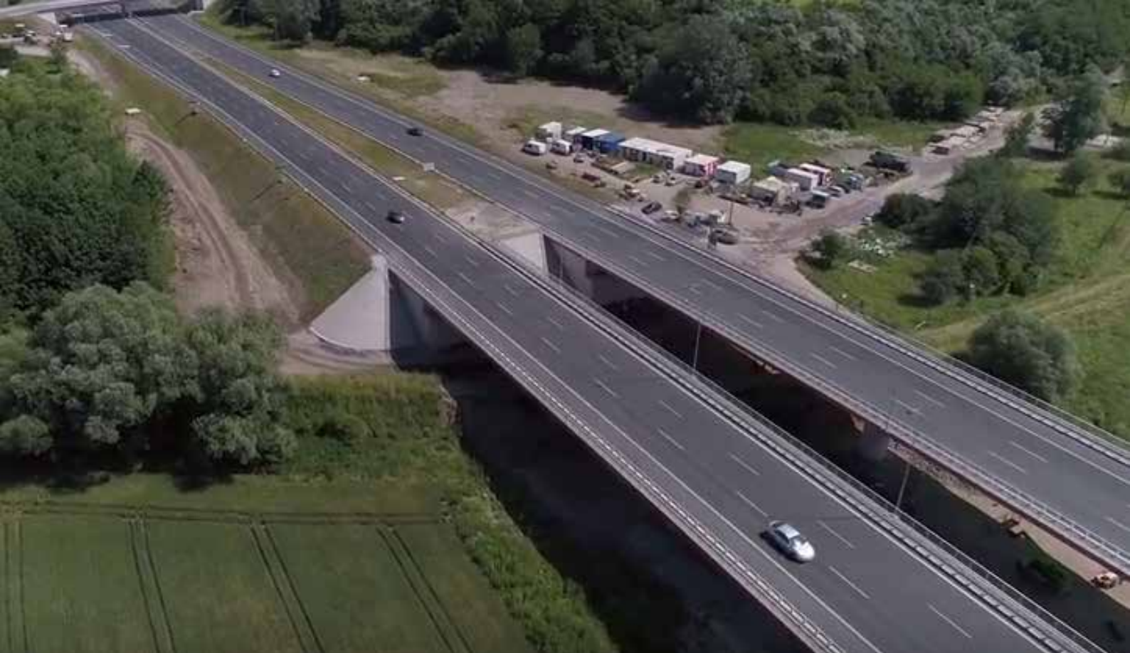
Fot. 2. Trasa nowohucka wykonana z asfaltu modyfikowanego gumą [16]
