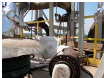
Przesycanie spoin rurociągu
