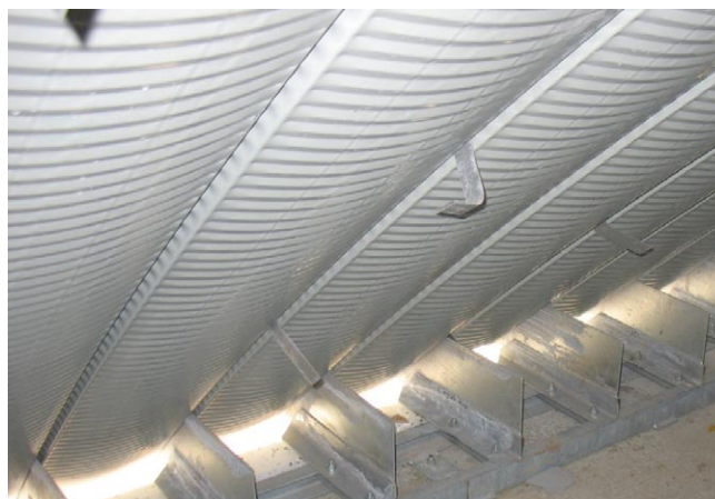
Rys. 13. Montaż powłoki do ściany lub fundamentu
