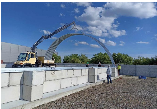
Rys. 12. Ustawianie segmentu montażowego
