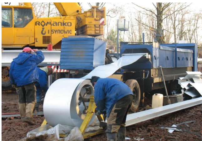
Rys. 8. Wprowadzanie wstęgi blachy do giętarki
