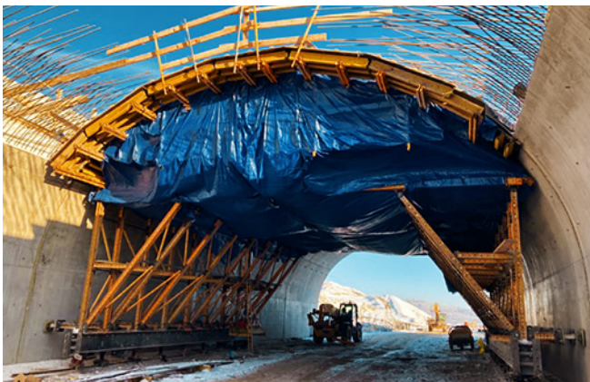
Ryc. 18. Strop tunelu TS-32
