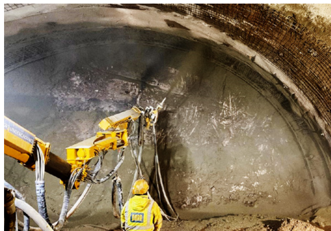
Ryc. 13. Wbudowywanie betonu natryskowego
