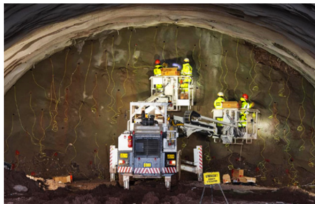
Ryc. 10. Ładowanie środków strzałowych
