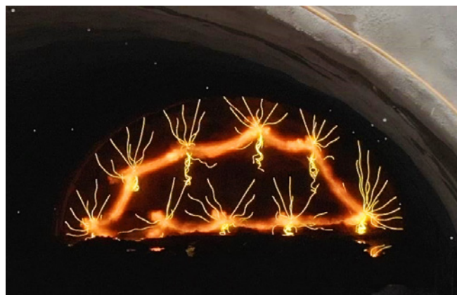
Ryc. 11. Moment wybuchu załadowanych ładunków
