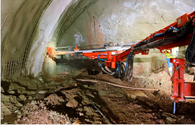
Ryc. 14. Wykonanie obudowy kotwionej
