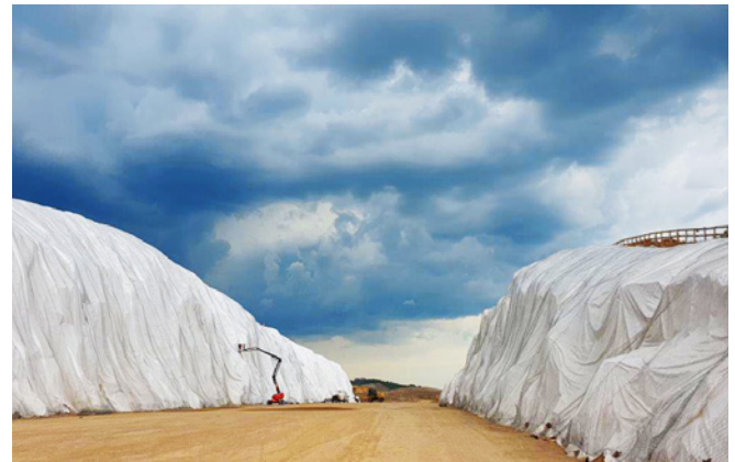
Ryc. 16. Zabezpieczenie ścian wykopu tunelu TS-32
