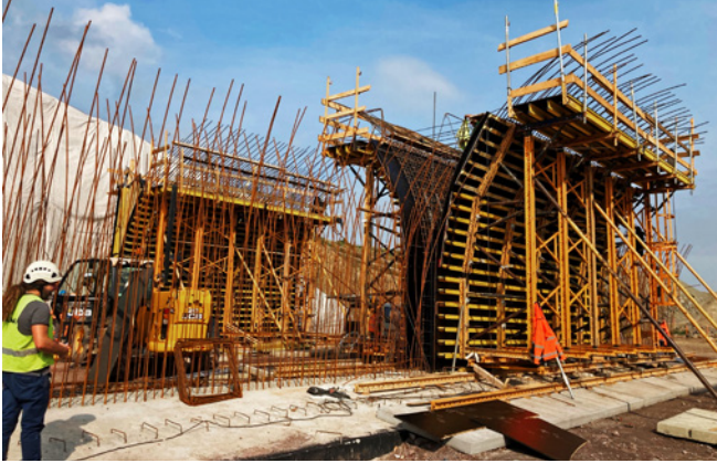
Ryc. 17. Ściany tunelu TS-32
