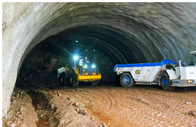
Ryc. 12. Wywóz urobku z tunelu
