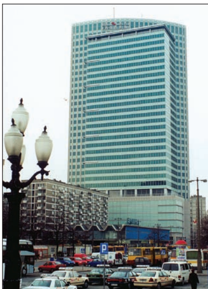
Fot. 1. Widok budynku Warszawskiego Centrum Finansowego o wysokości 144 m
