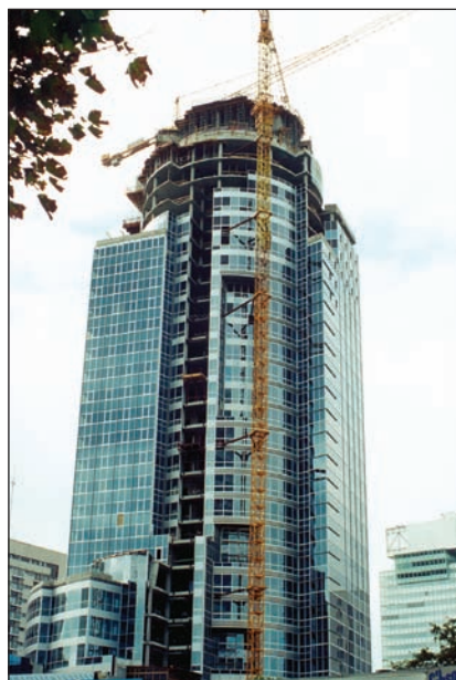
Fot. 2. Widok budynku TP SA w końcowej fazie budowy
