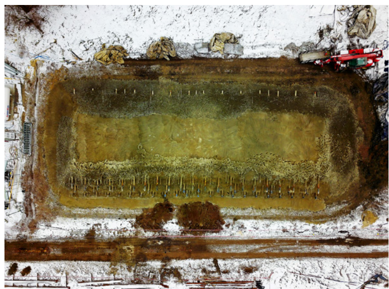
Ryc. 2. Przykładowa pryzma, w której prowadzony jest proces termicznej desorpcji
