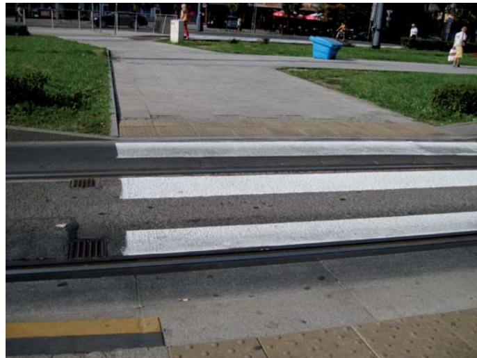
Fot. 3. Przejście dla pieszych przez torowisko w poziomie terenu, połączone z chodnikiem na przeciwnym końcu peronu to pożądana alternatywa dla dźwigów w dostępie do przystanku
