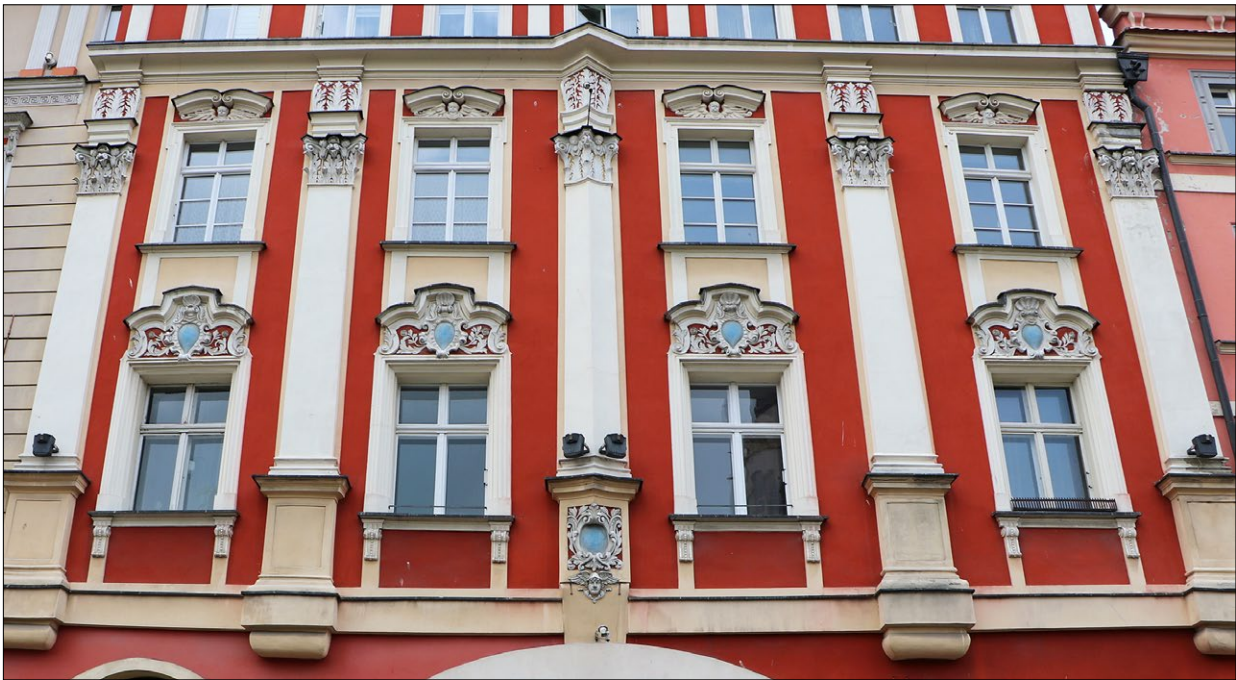
Ryc. 3. Fragment elewacji kamienicy nr 23a Fig. 3. Fragment of the facade of the house No. 23a
