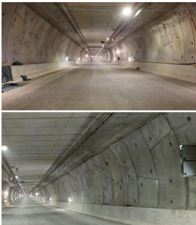
Rys. 1. Tunel pod Świną, Świnoujście
