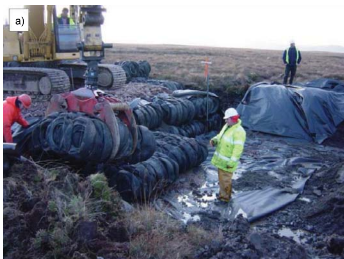
Fot. 4. Pakiety opon jako podbudowa drogi B-871, Szkocja: a) ułożenie pakietów opon na geosyntytyku separacyjnym; b) wypełnienie wolnych przestrzeni między pakietami kruszywem keramzytowym [18]
