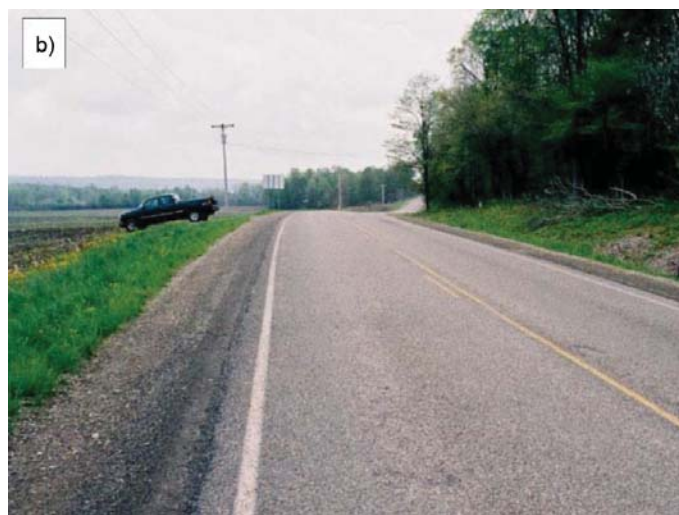
Fot. 3. Pakiety opon jako podbudowa dróg w hrabstwie Chautauqua, USA: a) ułożenie warstwy przykrywającej na pakietach opon; b) ukończona droga [17]
