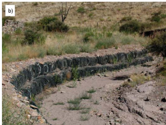
Fot. 6. Grawitacyjne konstrukcje oporowe z pakietów opon wykonane w a) Winston i b) Hillsboro, Nowy Meksyk, USA [19]
