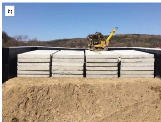
Fot. 7. Zasypka przyczółka mostowego w Sielnicy, Polska: a) ułożenie pojedynczej warstwy pakietów opon; b) przecięcie zasypki (A. Duda)
