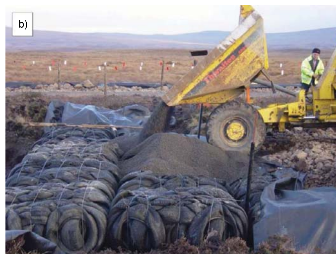
Fot. 4. Pakiety opon jako podbudowa drogi B-871, Szkocja: a) ułożenie pakietów opon na geosyntytyku separacyjnym; b) wypełnienie wolnych przestrzeni między pakietami kruszywem keramzytowym [18]
