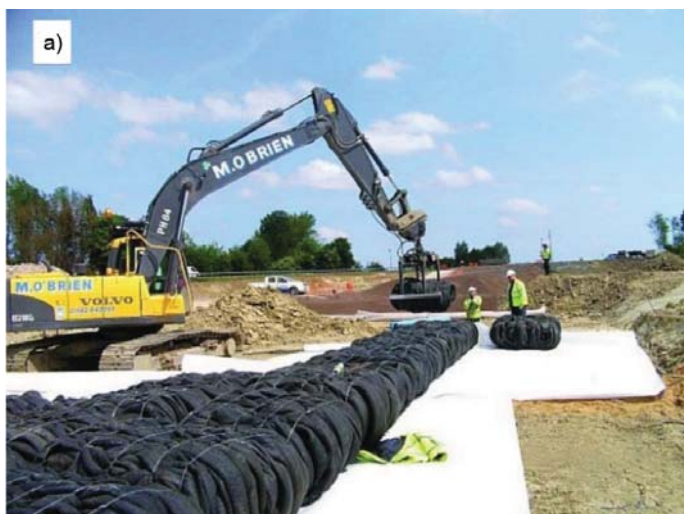
Fot. 1. Budowa lekkiego nasypu autostrady A-421, Anglia: a) pakiety opon umieszczone na geowłókninie; b) wypełnienie przestrzeni między pakietami keramzytem [13]
