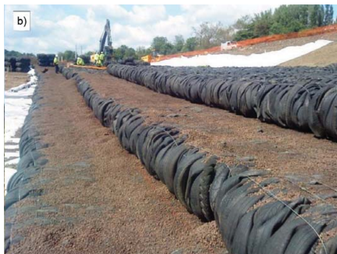
Fot. 1. Budowa lekkiego nasypu autostrady A-421, Anglia: a) pakiety opon umieszczone na geowłókninie; b) wypełnienie przestrzeni między pakietami keramzytem [13]
