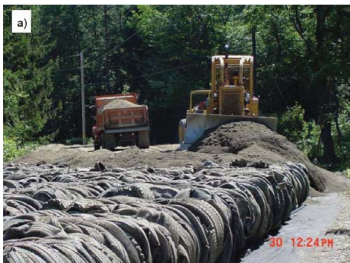
Fot. 3. Pakiety opon jako podbudowa dróg w hrabstwie Chautauqua, USA: a) ułożenie warstwy przykrywającej na pakietach opon; b) ukończona droga [17]
