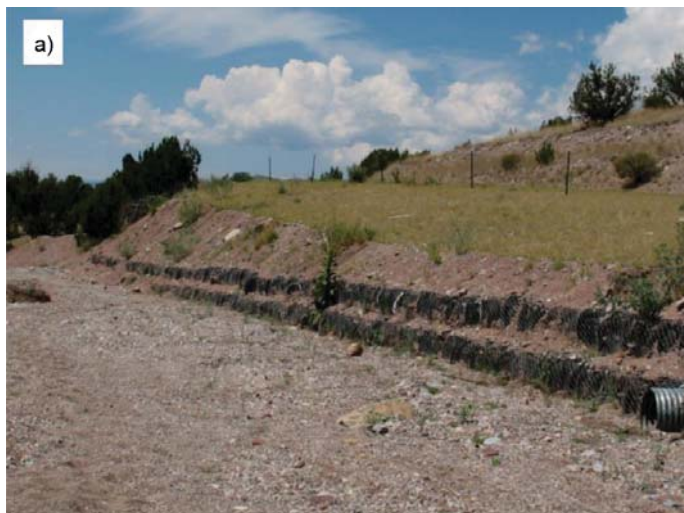
Fot. 6. Grawitacyjne konstrukcje oporowe z pakietów opon wykonane w a) Winston i b) Hillsboro, Nowy Meksyk, USA [19]
