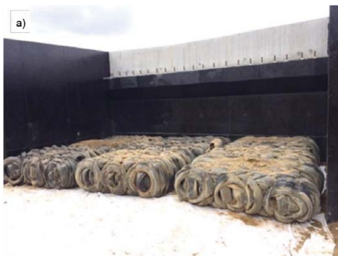
Fot. 7. Zasypka przyczółka mostowego w Sielnicy, Polska: a) ułożenie pojedynczej warstwy pakietów opon; b) przecięcie zasypki (A. Duda)
