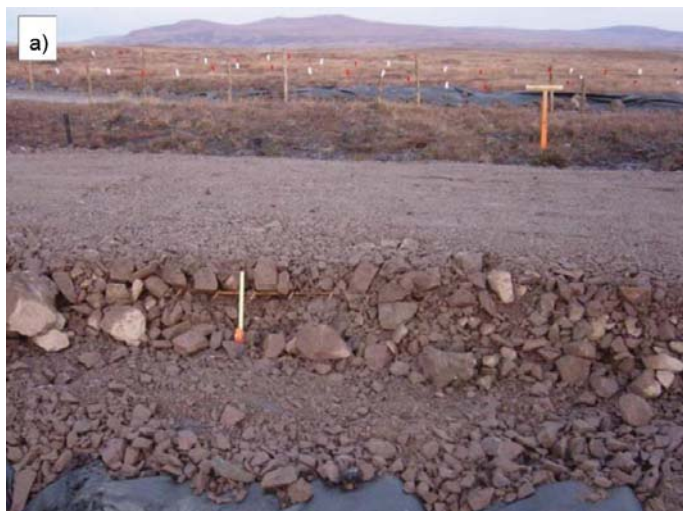
Fot. 5. Pakiety opon jako podbudowa drogi B-871, Szkocja: a) warstwa szutrowa przykrywająca pakiety opon wzmocniona siatkami stalowymi; b) droga B-871 po odbudowie nawierzchni i poboczy [18]
