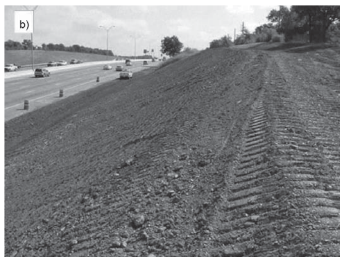
Fot. 2. Naprawa zbocza skarpy przy drodze I-30 w Fort Worth, USA: a) umieszczenie pakietów opon w podstawie skarpy; b) pakiety opon przykryte gruntem osuwiskowym z dopasowaniem pochylenia skarpy do otaczającego zbocza [16]
