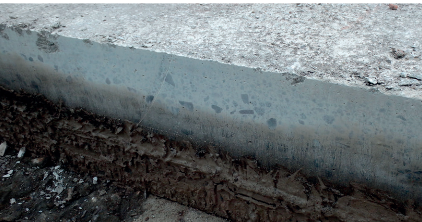
Płyta bez uszkodzeń z wyjątkiem punktu odwiertu
