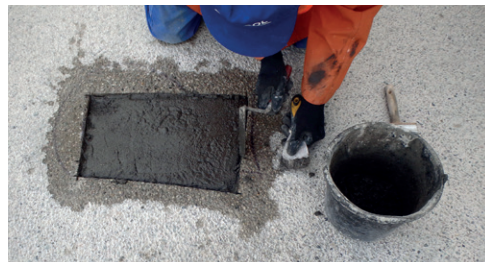
Wykuwanie punktowe GWB (powyżej) Wypełnianie specjalistyczną zaprawą (poniżej)
