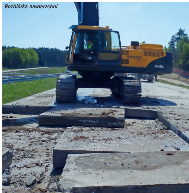
Rozbiórka nawierzchni
