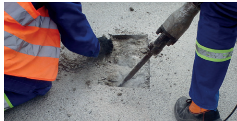
Wykuwanie punktowe GWB (powyżej) Wypełnianie specjalistyczną zaprawą (poniżej)
