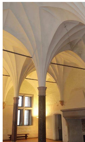
Rys. 8. Zarysowanie sklepienia w komnacie narożnej – rozwarcie do 2 mm
