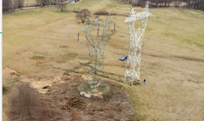
Stup wysokiego napięcia i jego cyfrowy bliźniak nałożony na zdjęcie
