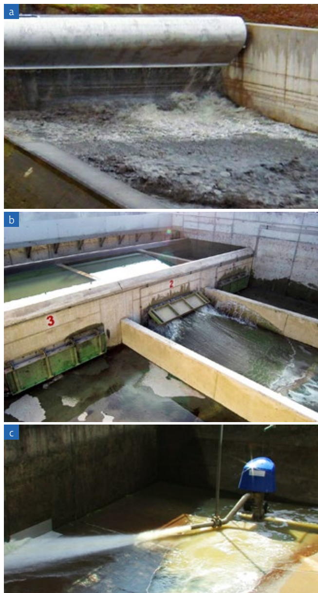
Ryc. 2. Urządzenia płuczące zbiorniki retencyjne: a) koryto płuczące, b) kłapa płuczająca, c) strumienica płuczająca, fot. HST Systemtechnik GmbH & Co. KG
