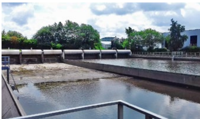
Ryc. 1. Krata typu HSR: a) krata zainstalowana na przelewie burzowym, b) zanieczyszczenia na kratce wywołujące efekt filtracji, fot. S. Mielczarek
