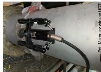
Pobieranie wycinka do badań z rurociągu
