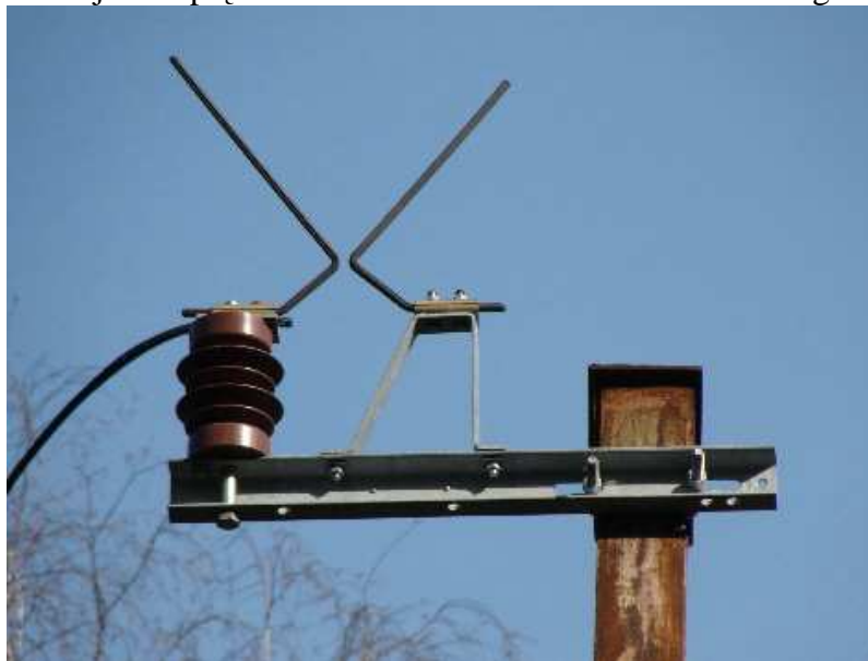
Rys.1. Nieprawidłowe rozstawienie elektrod wyładowczych w odgromniku rożkowym.
