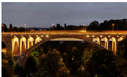
Ryc. 8. Widok mostu Adolphe w Luksemburgu i podwieszona do jego pomostu kładka, źródło: www.miesarch.com
