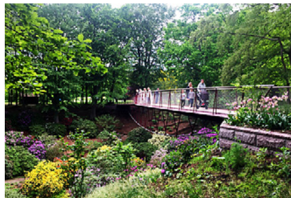
Ryc. 3. Kładka Sofiero w Helsingborgu w Szwecji, źródło: www.dissingweitling.com
