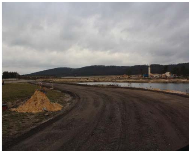
Rys. 11. Wykonywanie odcinka doświadczalnego; a) zespół maszyn w czasie pracy, b) widok wykonanej podbudowy z recyklowanej mieszanki MCAS (Fot. P. Buczyński)
