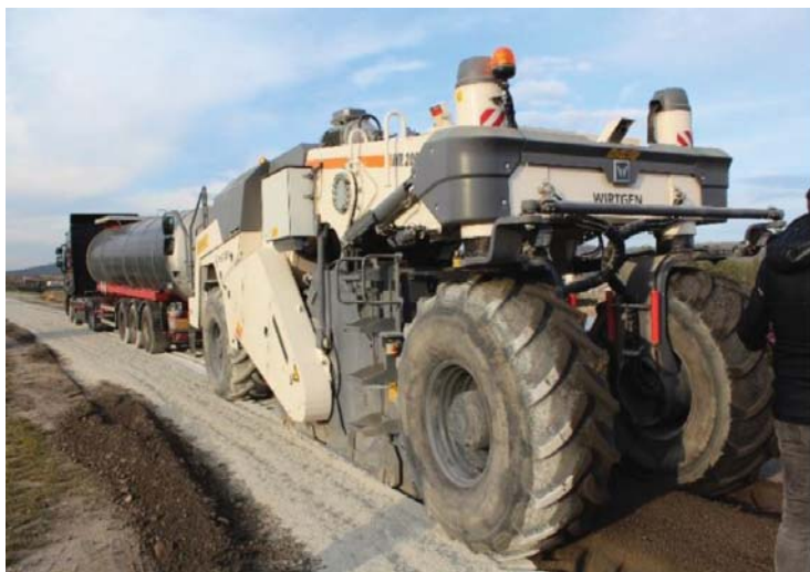
Rys. 11. Wykonywanie odcinka doświadczalnego; a) zespół maszyn w czasie pracy, b) widok wykonanej podbudowy z recyklowanej mieszanki MCAS (Fot. P. Buczyński)
