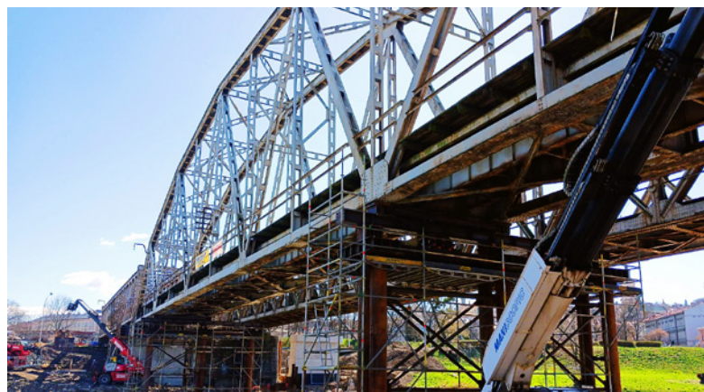
Remontowany most kolejowy w Przemyślu, fot. PKP PLK S.A.
