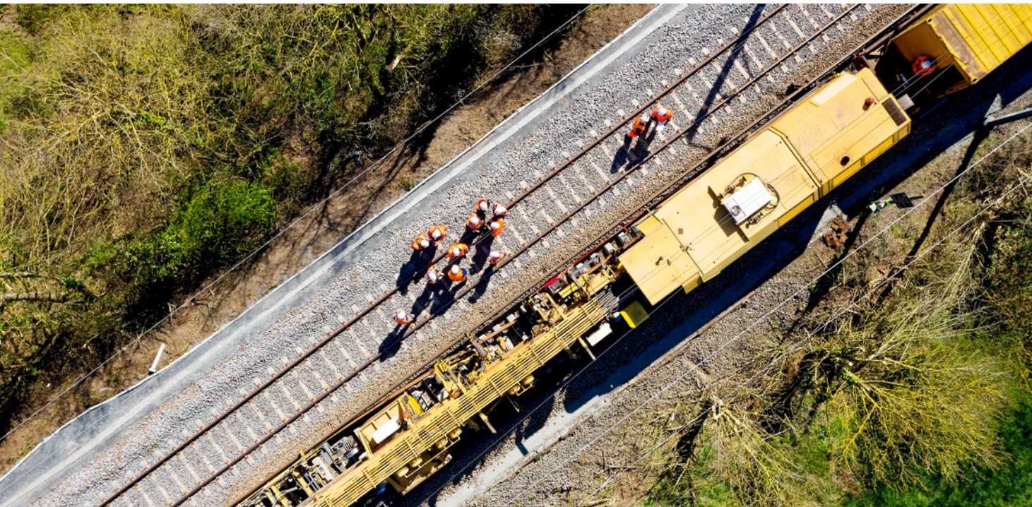
Prace modernizacyjne na sieci kolejowej, fot. altitudedrone, Adobe Stock
