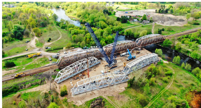
Remont mostu w Tomaszowie Mazowieckim, fot. P. Mieszkowski
