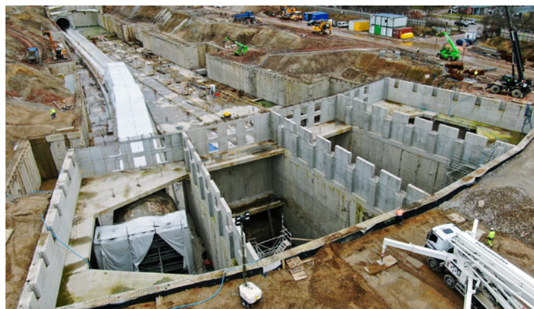
Budowa przystanku Koziny w Łodzi, fot. PKP PLK S.A.
