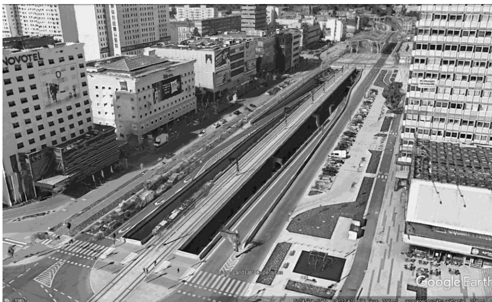
Rys. 20. Łódź – Trasa WZ. Model trójwymiarowy pokazujący szczeliny wentylacyjne pasów szybkiej trasy i rampy łączące. Daleko w głębi dach nad węzłem tramwajowym. Przejścia naziemne zastąpiły tunele dla pieszych [Google Earth]
