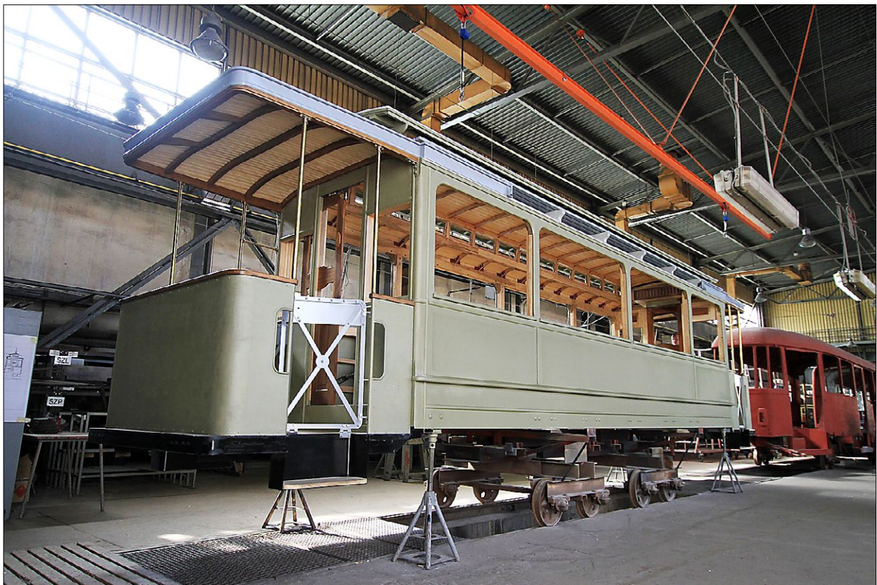
Ryc. 4. Stan nadwozia po restauracji do stanu surowego w 2015; fot. K. Kokot.
