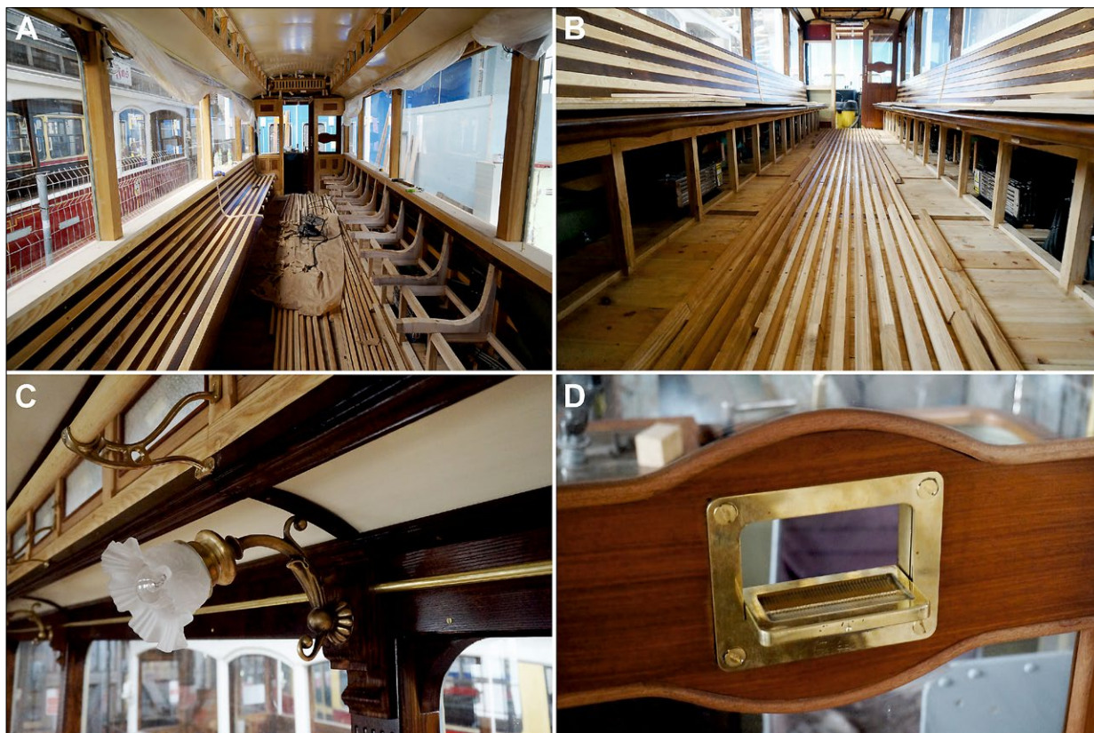
Ryc. 8. Odtwarzanie wnętrza wagonu: A – prace przy ławkach, które są ułożone wzdłuż ścian bocznych, a ich siedziska składają się z naprzemiennych ciemnych i jasnych szczeblin; B – układanie desek o przekroju trapezu na podłodze; pod ławkami widoczne grzejniki; C – jedna z odtworzonych lamp i mosiężny wspornik poręczy; D – okienko do sprzedaży biletów w drzwiach między pomostem a przedziałem pasażerskim; fot. K. Kołodziejczyk.
