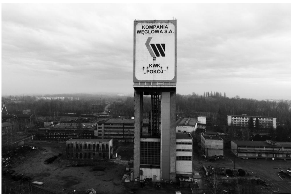
Rys. 2. Górąca nad terenem wieża nadszybia szybu Wanda [Stangel 2021]
