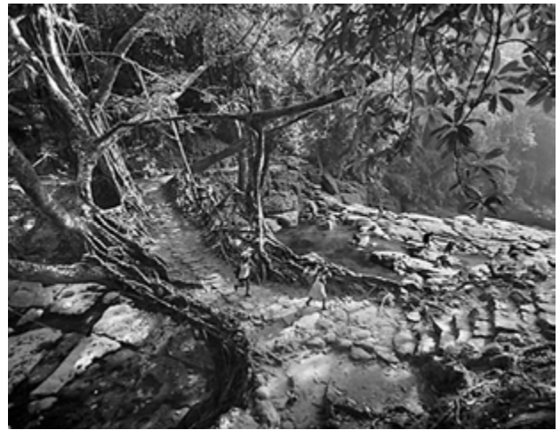
7. Konstrukcja „żywego mostu” uzupełniona kamieniami. Źródło: http://humanplanet.com/timothyallen/2011/03/living-root-bridges-bbc-human-planet/
