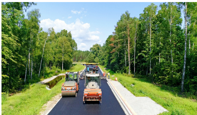
DW604 – ze względu na ochronę środowiska i poprawę komfortu życia mieszkańców oraz turystów inwestor, ZDW w Olsztynie, zdecydował się na cichą nawierzchnię asfaltową z drobnziarnistej mieszanki SMA 8 z MODBIT 45/80-65
