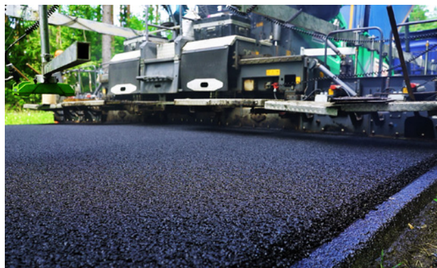
Zastosowanie asfaltów o podwyższonym stopniu modyfikacji MODBIT 45/80-65 na DW604 wymagało od wykonawcy, firmy STRABAG, dobrej logistyki transportu, układania i zagęszczania ze względu na dużą lepkość asfaltu
