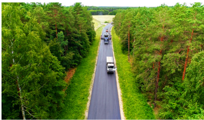
Przykład cichej nawierzchni z MODBIT 45/80-65 na drodze samorządowej. Rozbudowa drogi wojewódzkiej nr 604 na odcinku Robaczewo – Drogowy Odcinek Lotniskowy – Wielbark, biegnącej przez tereny leśne
