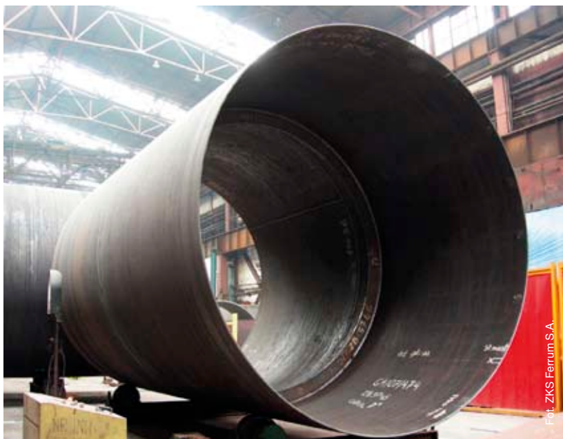
Fot. 1. Prefabrykacja płaszcza zewnętrznego zbiornika LPG
