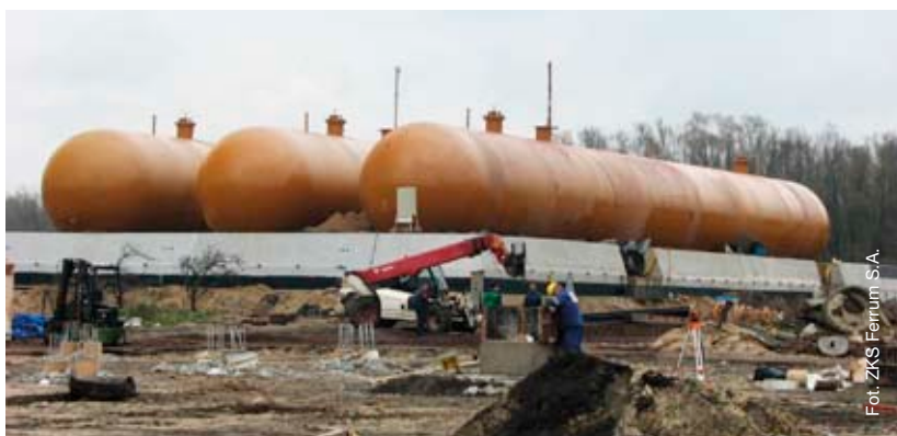
Fot. 6. Baza magazynowa zbiorników LPG w trakcie instalowania
