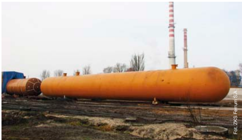
Fot. 5. Zbiorniki LPG o pojemności V1500 m 3 w trakcie montażu
