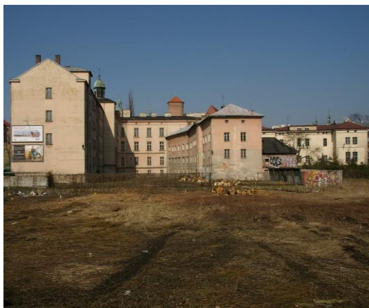
II.3. Widok zespołu budynków sprzed przebudowy, autor Rafał Wypalacz, (źródło: http://www.skyscrapercity.com/showthread.php?t=537519&page=4 ),
