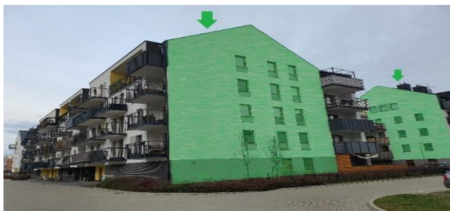
Rys. 16. Elewacja na osiedlu Perspektywa [A. Osiak]
