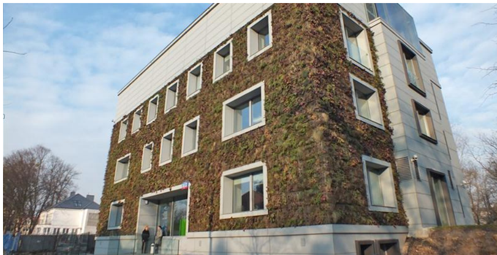
Rys. 8. Przykład zielonej ściany budynku Fundacji Nauki Polskiej w Warszawie – zimą [Clematis 2023]
