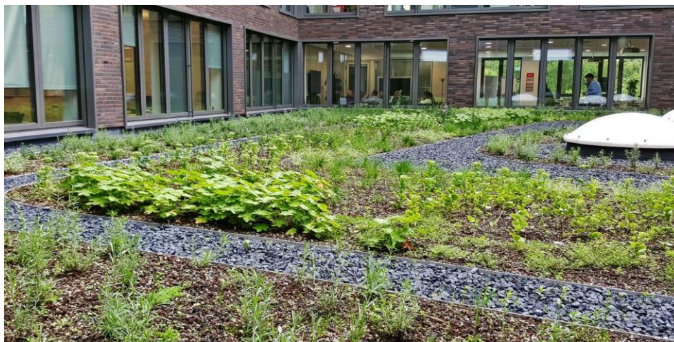
Rys. 3. Przykład dachu ekstensywnego [GCL 2023]
