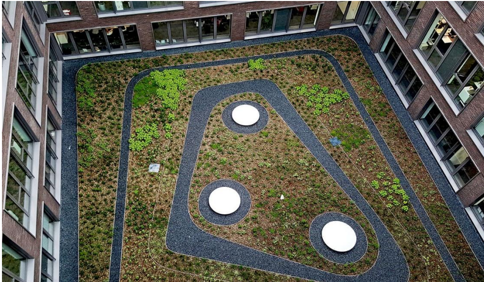
Rys. 2. Przykład dachu ekstensywnego [GCL 2023]
