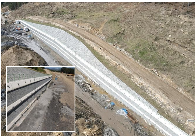
Rys. 7. Ściana oporowa nr 4
