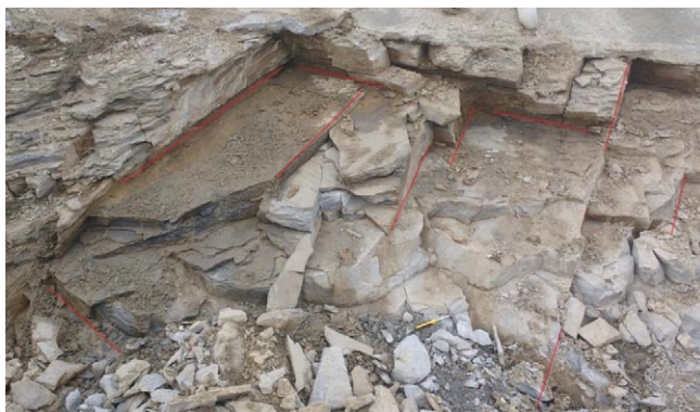
Rys. 2. Kilometraż 32+120 – 32+426 drogi S1, ściana oporowa nr 3; układ spękań ciosowych piaskowców, kąt upadu warstw skalnych 36°
