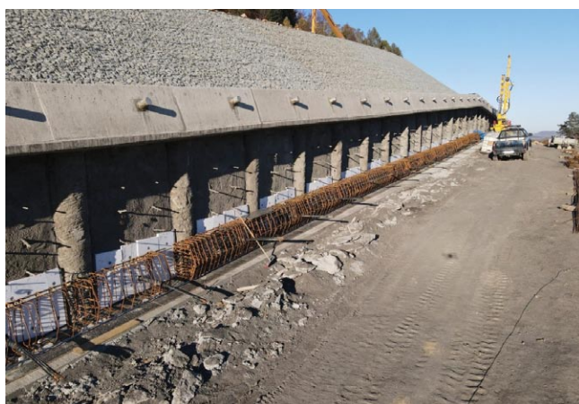
Rys. 5. Ściana oporowa nr 4 w trakcie realizacji
