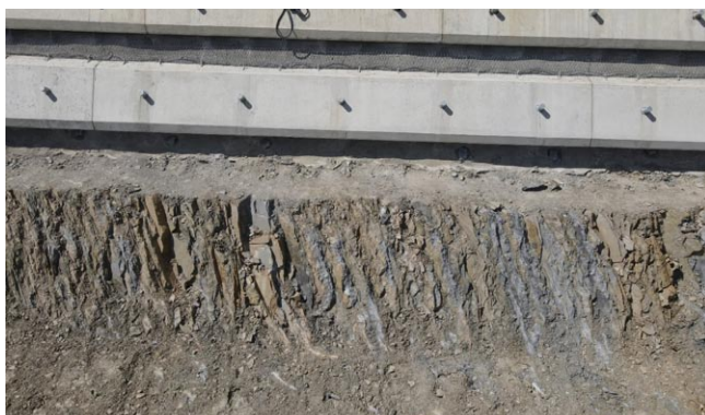
Rys. 3. Kilometraż 34+793 – 34+983, ściana oporowa nr 2; skała piaskowcowa, kąt upadu warstw skalnych od 60 do 75°
